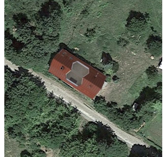
Aufsicht der Dachöffnung
